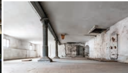
Zwei Einblicke in das Georgianum vor der Sanierung Fotos: Marc Köschinger
