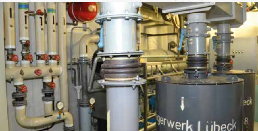
Immer wieder finden sich in den Anlagen Elemente aus Gummi, damit sich Geräte und Maschinen bei einem möglichen Bombenangriff „mitbewegen“ können.
